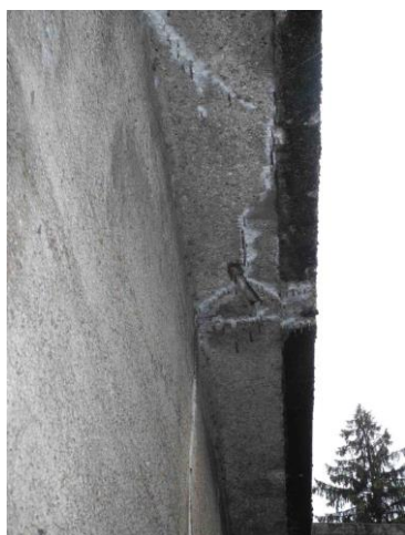
Vyústění odvodňovače na začátku 3.pole vpravo
