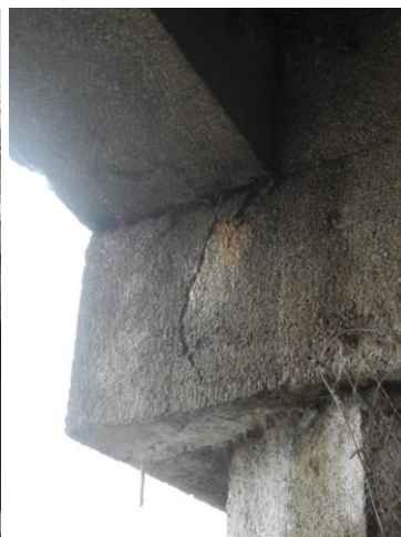
Podpěra 5 - trhлина na stativu ze strany 5.pole vpravo
