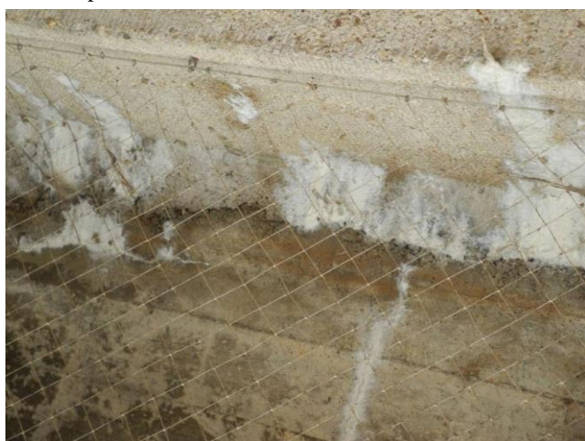
Pole 5 - trhlina mezi deskou mostovky a levým trámem
