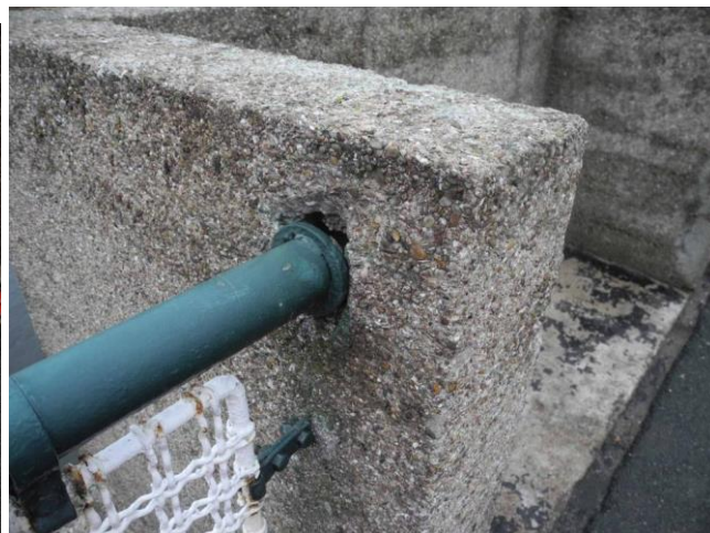
Uvolněné horní madlo pravého zábradlí uprostřed délky 1.pole
