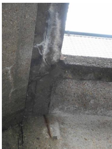
Podpěra 1 - dilatace mezi baloknem a nosnou konstrukcí
