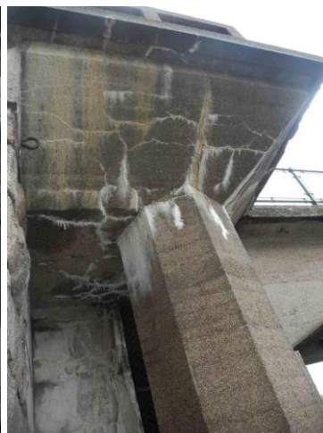
Podpěra 1 - dilatace mezi balkónem a nosnou konstrukcí
