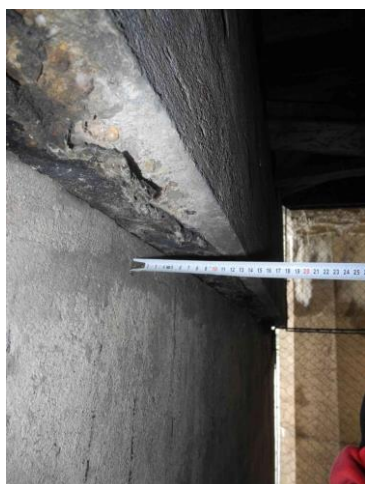
Podpěra 1 - vysunutí dříku podpěry
