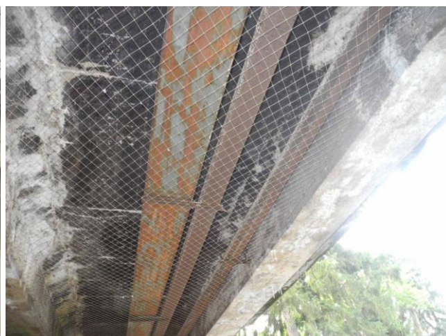
Pole 6 - trhlina mezi deskou mostovky a pravým trámem
