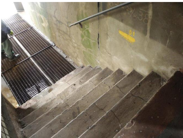
Podpěra 4 - trhliny na konstrukci schodiště
