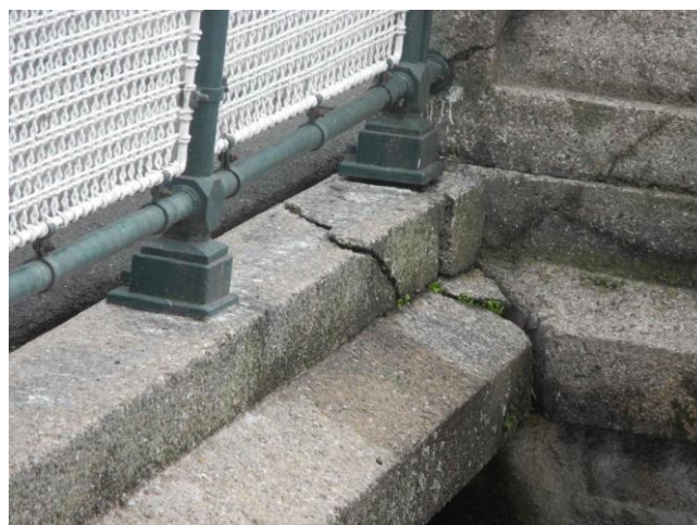
Prasklá pravá římsa před podpěrou 3 - detail
