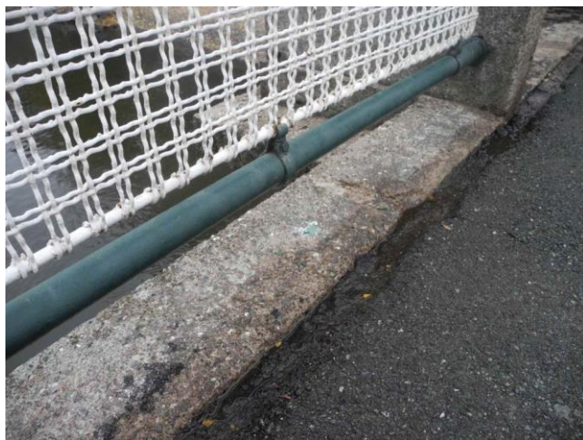
Povrchově zvětralý beton pravé římsy
