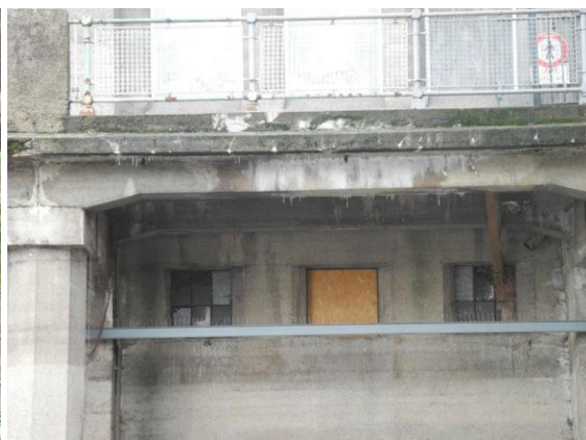
Pole 7 - protékání vpravo
