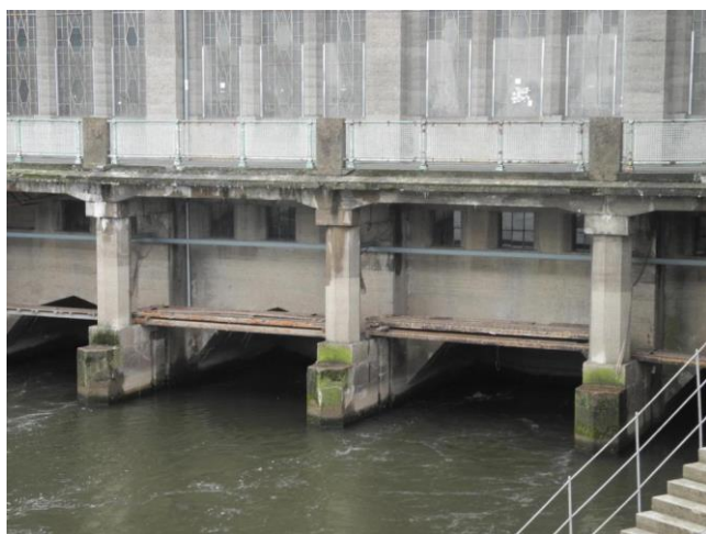
Mezilehlé podpěry v elektrárenské části
