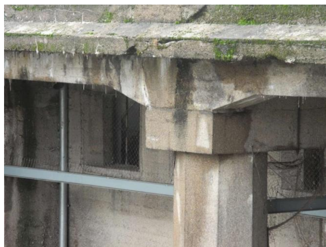
Podpěra 6 - uložení nosné konstrukce
