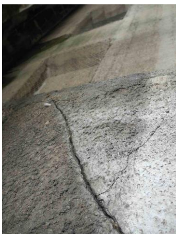
Podpěra 4 - levý sloup 5.pole - detail trhliny
