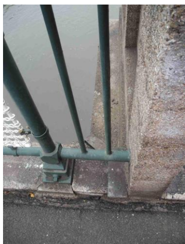
Balkon nad podpěrou 2 - zkorodovaný krycí plech dilatace
