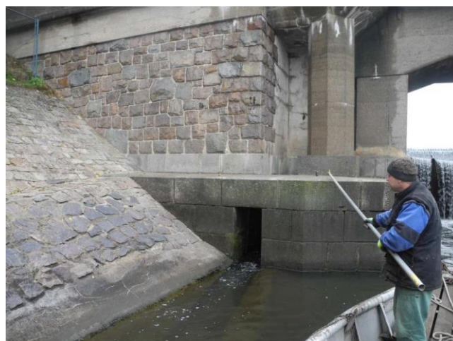
Rybí propust u opěry na začátku mostu
