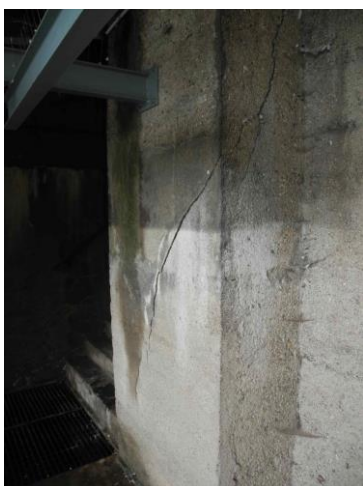
Podpěra 4 - prasklina na levém sloupu 4.pole
