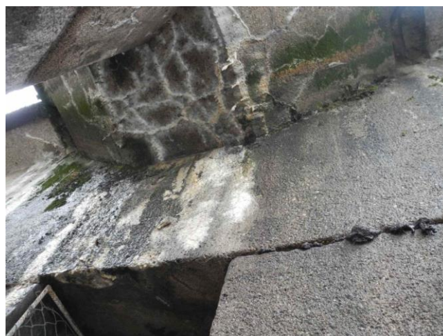
Podpěra 2 - konstrukce balkonu a dilatace
