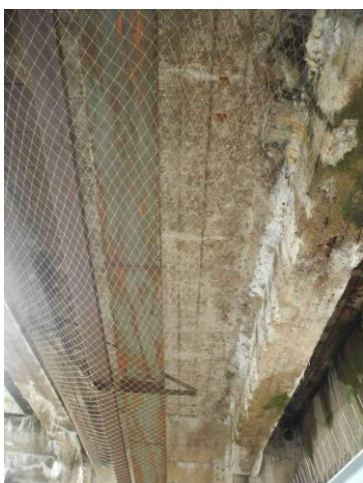
Pole 4 - proteklá trhlina mezi levým trámem a deskou mostovky
