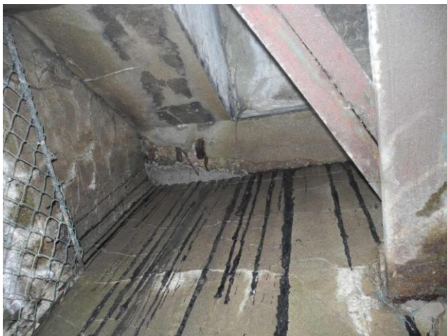
Sanovaný pohled pravého zakončení nosné konstrukce u opěry na začátku lávky
