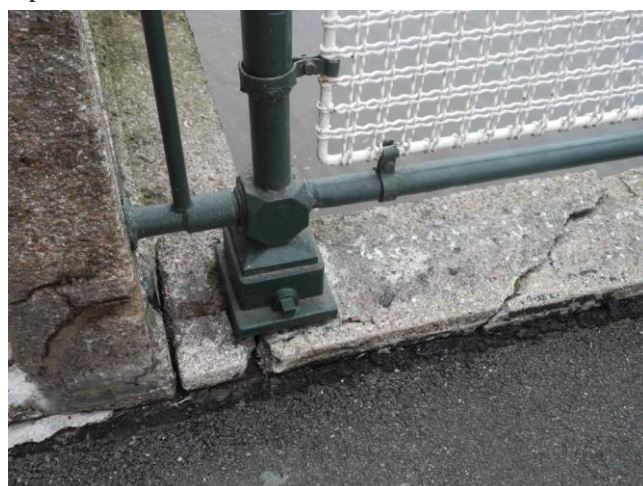
Kotvení pravého zábradelního sloupku na konci 3.pole
