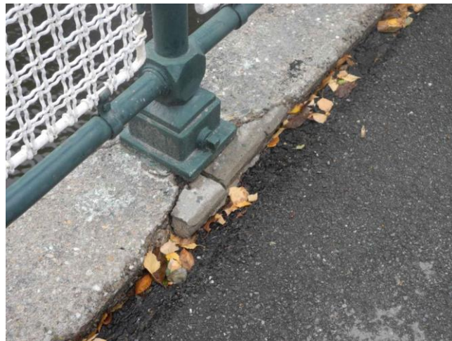
Detail kotvení zábradlí (jezová část)
